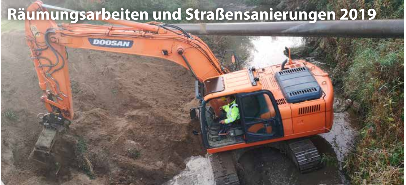
Räumungsarbeiten in der Ilz
