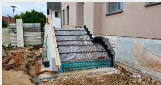
BEWÄHRUNG UND SCHALUNG AUSSENSTIEGE
