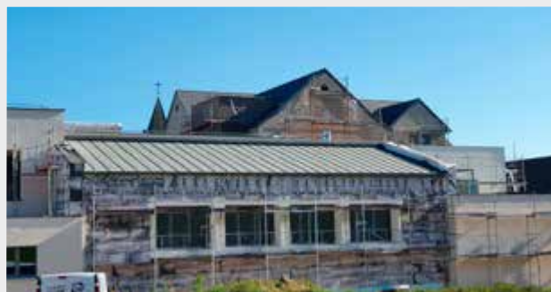
WÄRME-DÄMM-VERBUND-SYSTEM (WDVS): FASSADENARBEITEN BEIM NEUBAU UND TURNSAAL
