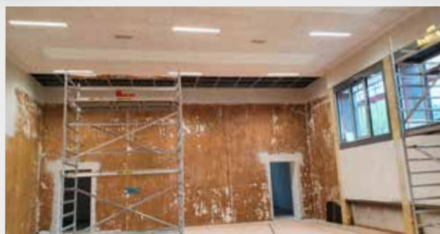
FERTIGSTELLUNG TURNSAALDECKE UND ABBRUCH DES TURNSAALBODENS
