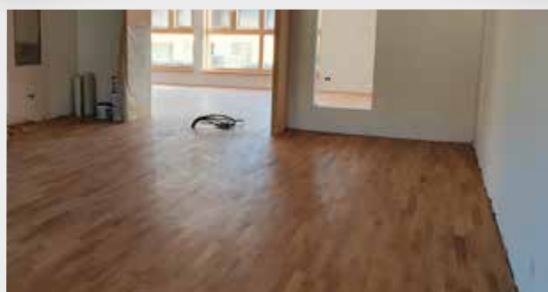
BEGINN VERLEGUNG PAKETTBÖDEN UND MONTAGE HOLZPORTALE
