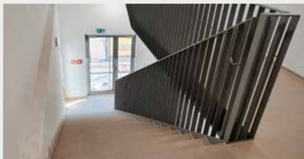
FLIESENLEGEARBEITEN UND GELÄNDERMONTAGE IM ALTBAU
