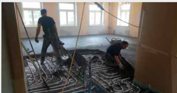
FUSSBODENHEIZUNG, ESTRICH UND INNENPUTZ SIND FERTIG
