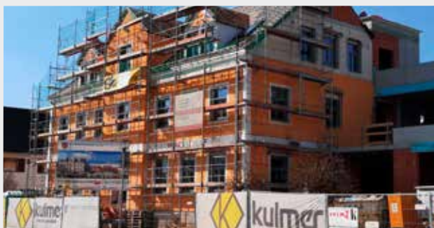
DIE FENSTER IM ALTBAU SIND EINGEBAUT
