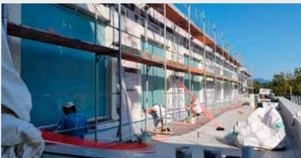
"WDVS" (WÄRMEVERBUNDSYSTEM) – FASSADENARBEITEN – BEIM NEUBAU
