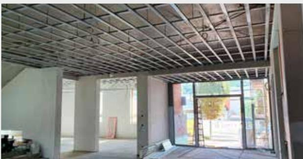
MONTAGE UND BEPLANKUNG DER ABGEHÄNGTEN DECKEN IN KIGA UND VS NEUBAU
